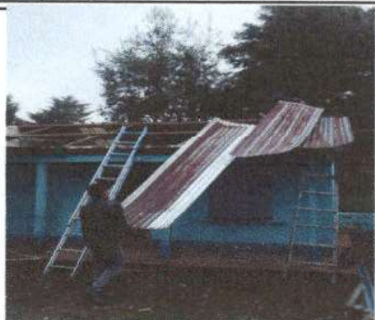
Foto 1: Sustrucción de lamina por lamina troquelada aluzinc calibre 26
