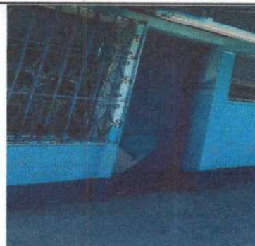
Foto 4: Mantenimiento a estructura (lijado, cambio de tubo, sepillado, sujecion y aplicacion de pintura) a puertas de servicios sanitarios
